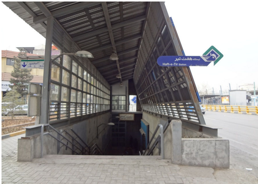
شکل ۴ ورودی زیرگذر هفت تیر
