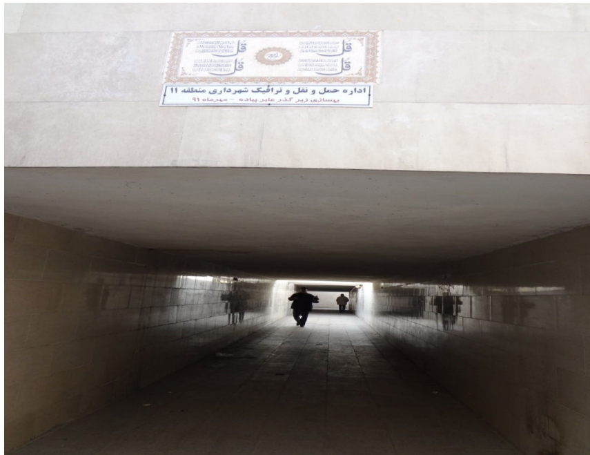
شکل ۳ فضای بی دفاع - پل زیرگذر واقع در بلوار استقلال
