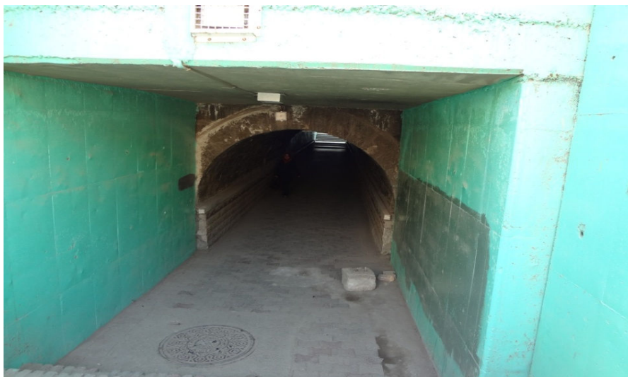
شکل ۲ فضای بی‌دفاع- پل زیرگذر واقع در بزرگراه شهید کلانتری
