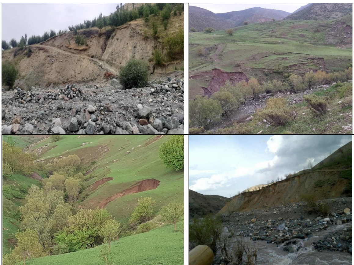
شکل ۲- برخی از زمین لغزش‌های رخ داده در حوضه آبخیز چریک آباد
