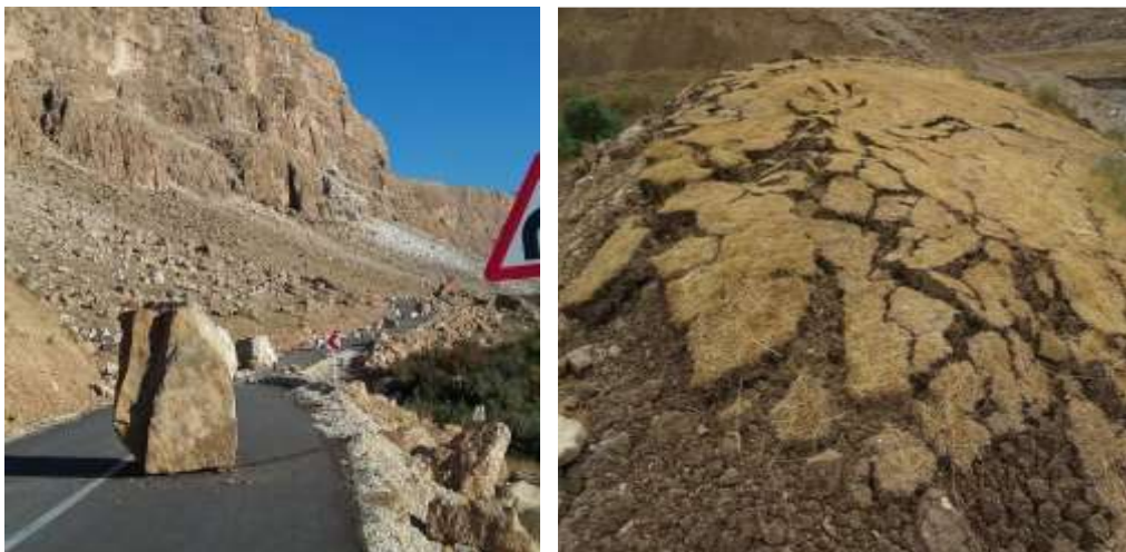
ج) ریزش سنگی دره بابایادگار گسیختگی تاج تپه‌ها جنوب شرق پاسگاه دارزنگنه
