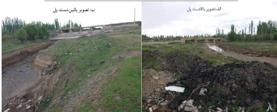
شکل ۸- تصاویر پل سرنق.
