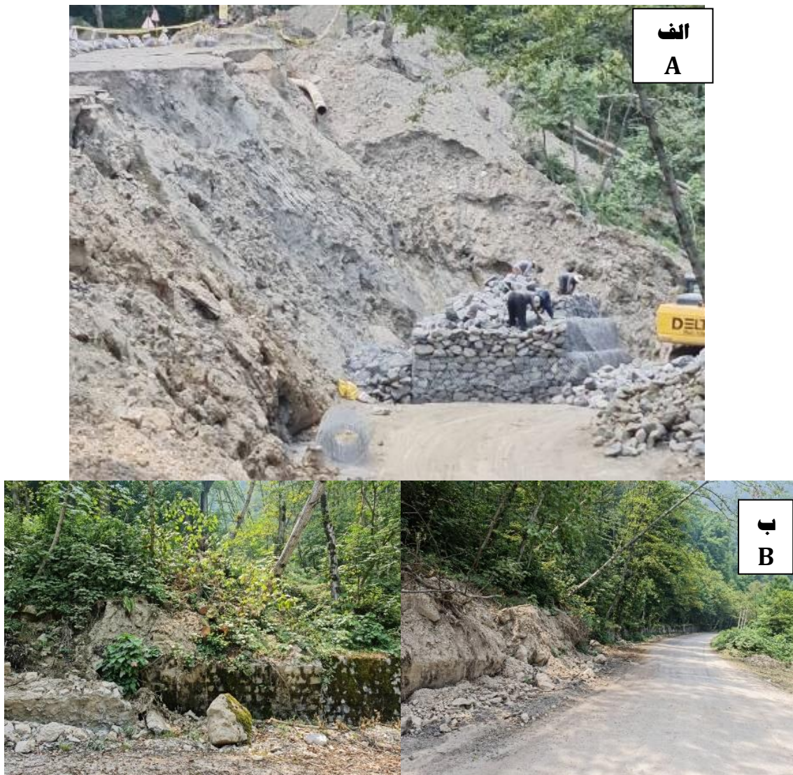
شکل ۱۲- نمونه‌هایی از دخالت انسانی در حوضه گلندرود و اتفاق افتادن حرکات دامنه‌ای: الف) زمین لغزش، ب) خزش
