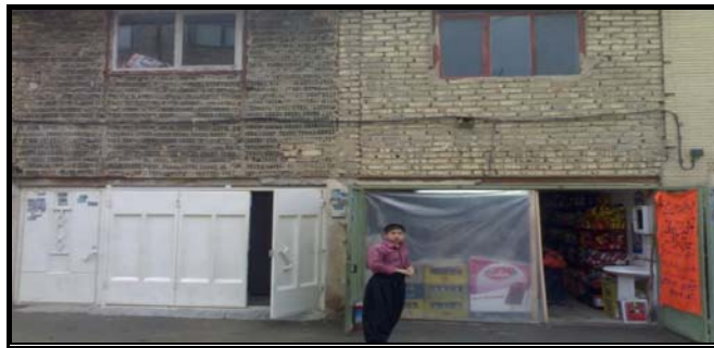
شکل ۸ کاربری تجاری طبقه همکف، بازشوهای بزرگ و عدم رعایت نسبت طول به عرض
