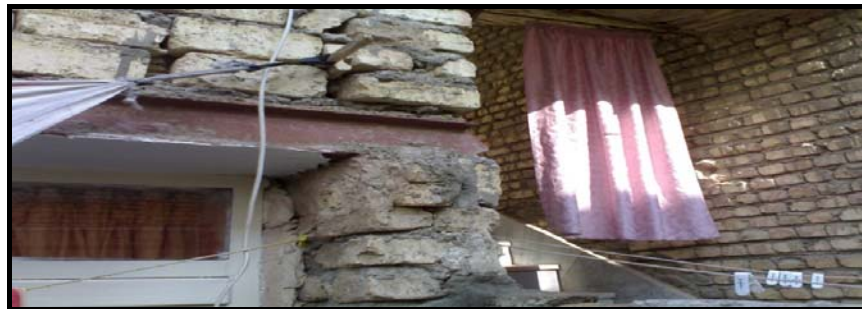
شکل ۶ قرارگیری تیرهای سقف مستقیماً بر روی دیوار
