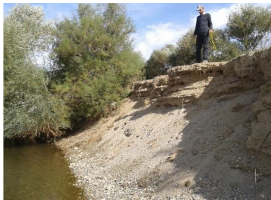
شکل ۱۶ سیلاب‌های لب‌پری و لب‌ریزی باعث فرسایش شدید کناره‌های فرسایش‌پذیر می‌شوند
