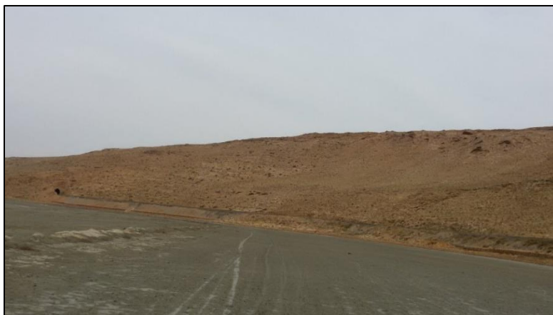
شکل ۱۲- تونل و راه آهن تبریز - تهران در انتهای مسیر حرکت گسل نرمال راست بر داشکسن همراه با توسعه فرسایش حفره‌ای ناشی از تخریب شیمیایی سنگ‌ها، جهت دید (N75E).
