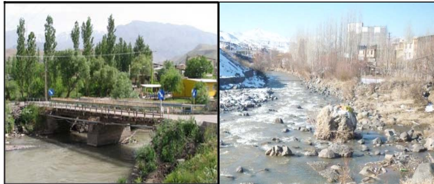
شکل ۲ سازه‌های احداث شده در مسیر رود شامل، پل در سمت راست و سازه‌های مسکونی در سمت چپ
