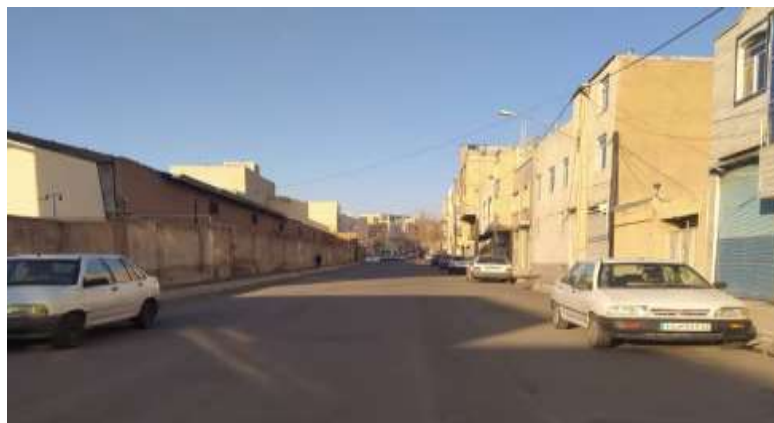
شکل ۷- علاوه بر وجود بافت فرسوده وسیع در منطقه ۳، بیشتر ساختمان‌ها نیز از آسیب‌پذیری بالایی برخوردار بوده که باعث کاهش تاب‌آوری در برابر زلزله می‌گردد.
