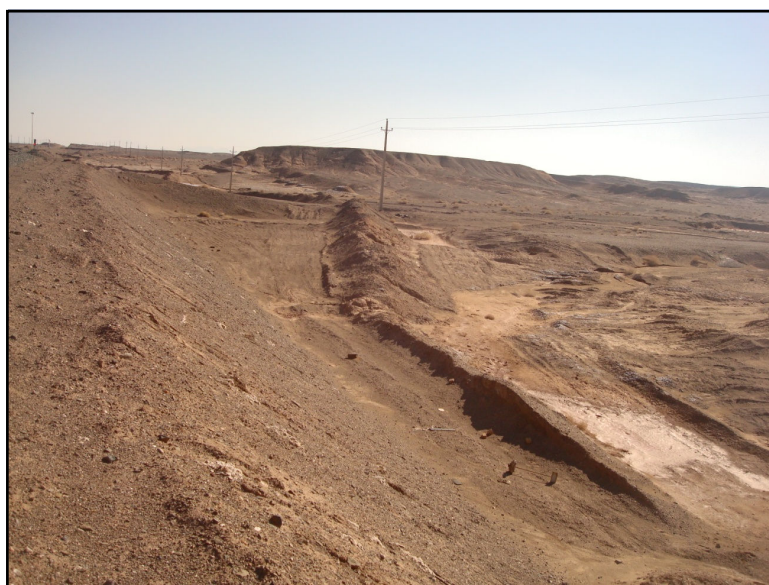
شکل ۱۱ فرسایش شدید در کنار ریل راه آهن کیلومتر بعد از ایستگاه رمل کیلومتر ۱۴۵
