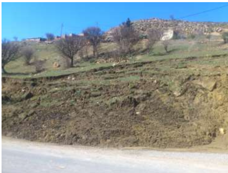
شکل ۴- وقوع زمین لغزش ناشی از احداث جاده و از بین رفتن تکیه گاه دامنه شیب دار (منبع: نگارندگان، ۱۳۹۹)
