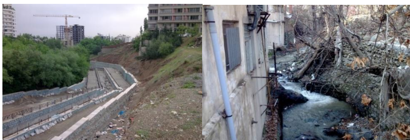
شکل ۱۲- تجاوز به حریم مسیل و رود-دره‌های دارآباد و ولنجک و ساخت‌وساز در حریم آنها
