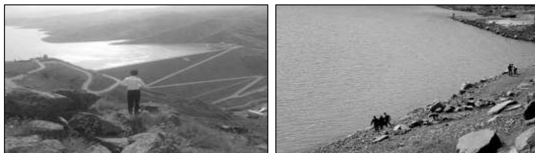
شکل ۸- ریزش های سنگی در نزدیکی سد شهرچایی ارومیه
