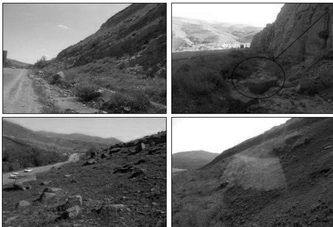
شکل ۷- فرسایش و خردایش سنگها و تجمع آنها در پای دامنه های مشرف به جاده موصلاتی
