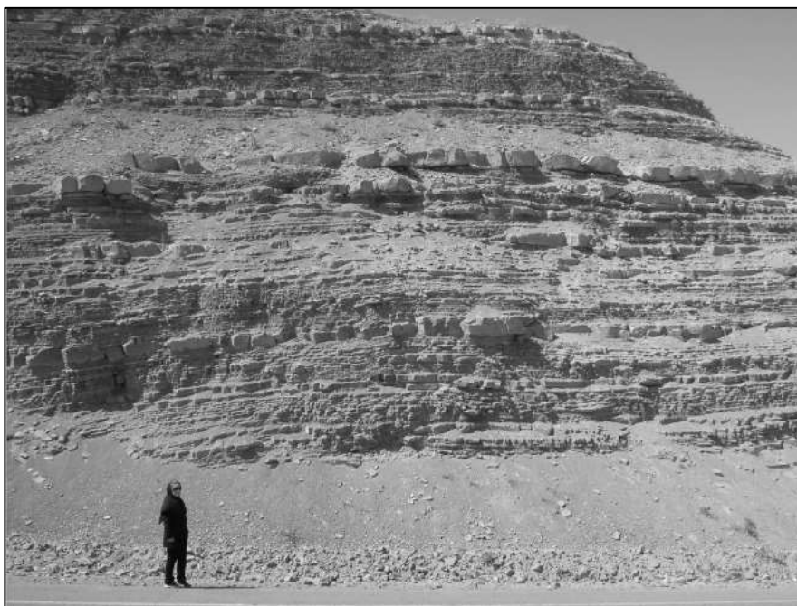
شکل ۱۲- وجود درزه‌های فراوان در دیواره‌های سنگی مشرف به جاده موصلاتی
