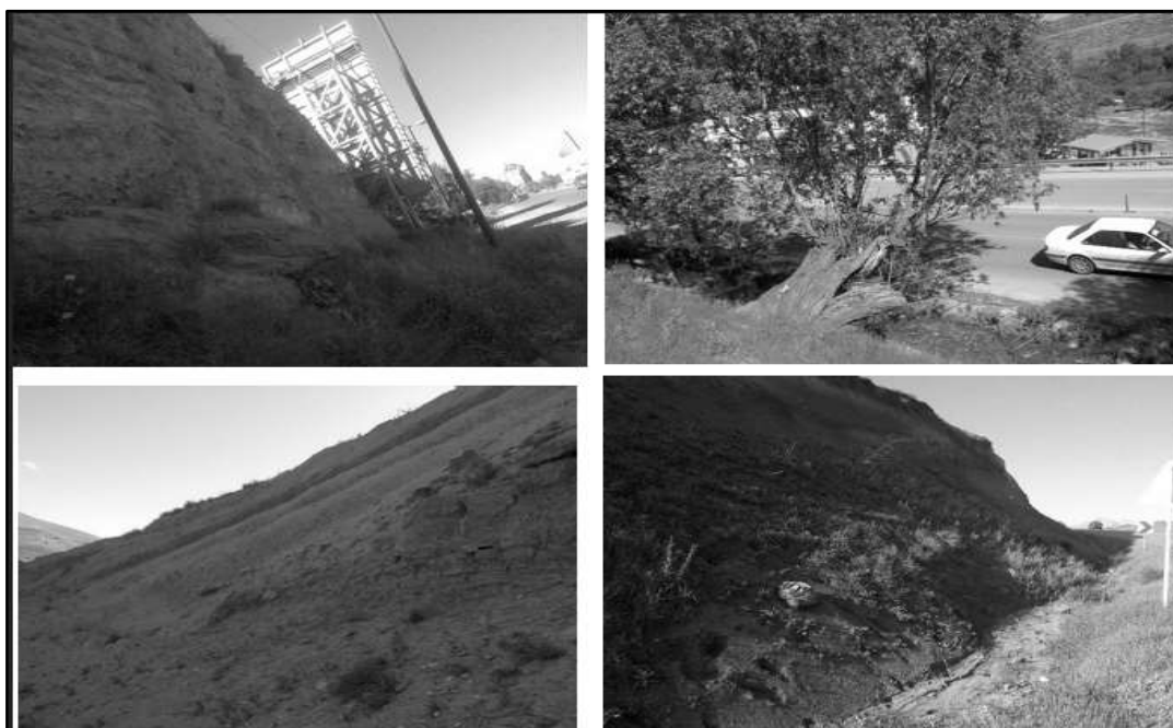
شکل ۱۰- وجود پدیده خزش و رسوبات آبرفتی سست با ارتفاع بیش از ۷ متر نزدیک به جاده موصلاتی
