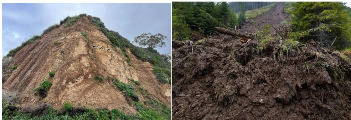
شکل ۱۳- رخداد زمین لغزش در نزدیکی شهر آستارا. شکل ۱۴- دامنه مستعد رخداد لغزش در گردنه حیران Fig.14. Landslide-Prone Slopes in Heyran Pass Fig.13. Landslide Occurrence, Astara City.
