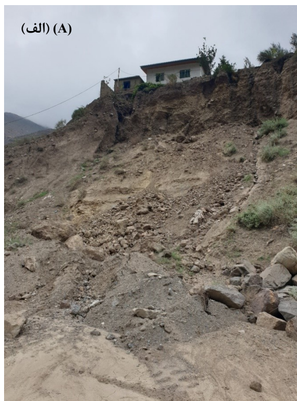
شکل ۲- نمونه‌ای از زمین‌لغزش (الف) و دیواره حائل جهت (ب) جلوگیری از ریزش سنگ در قسمت‌های سیاه بیشه و پنجاب در حاشیه جاده هراز
